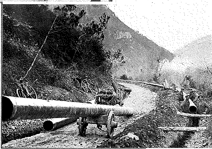
c AMENÉE DE TUBES A PIED D'ŒUVRE LE LONG DU TRACÉ. c SUR REMORQUE. d EN TERRAIN DE MONTAGNE D'ACCÈS DIFFICILE. e AU MOYEN D'ENGINS DE LEVAGE TOUS TERRAINS.
